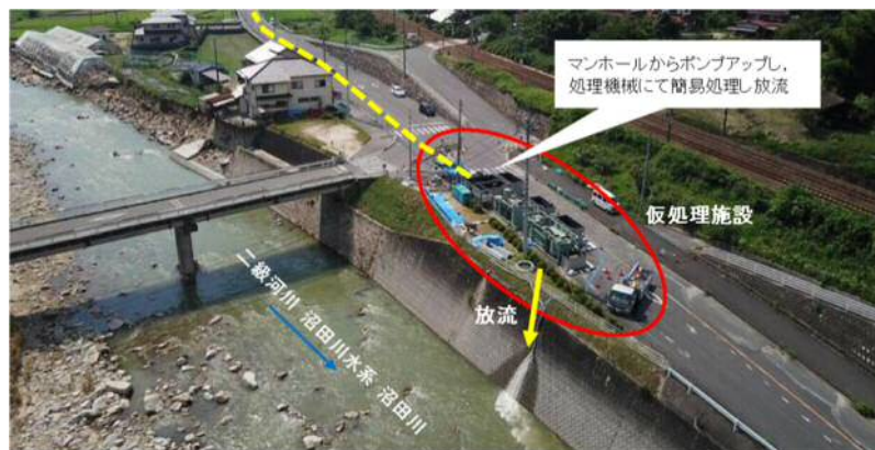
図2-17 沼田川流域下水道幹線（東広島市）
