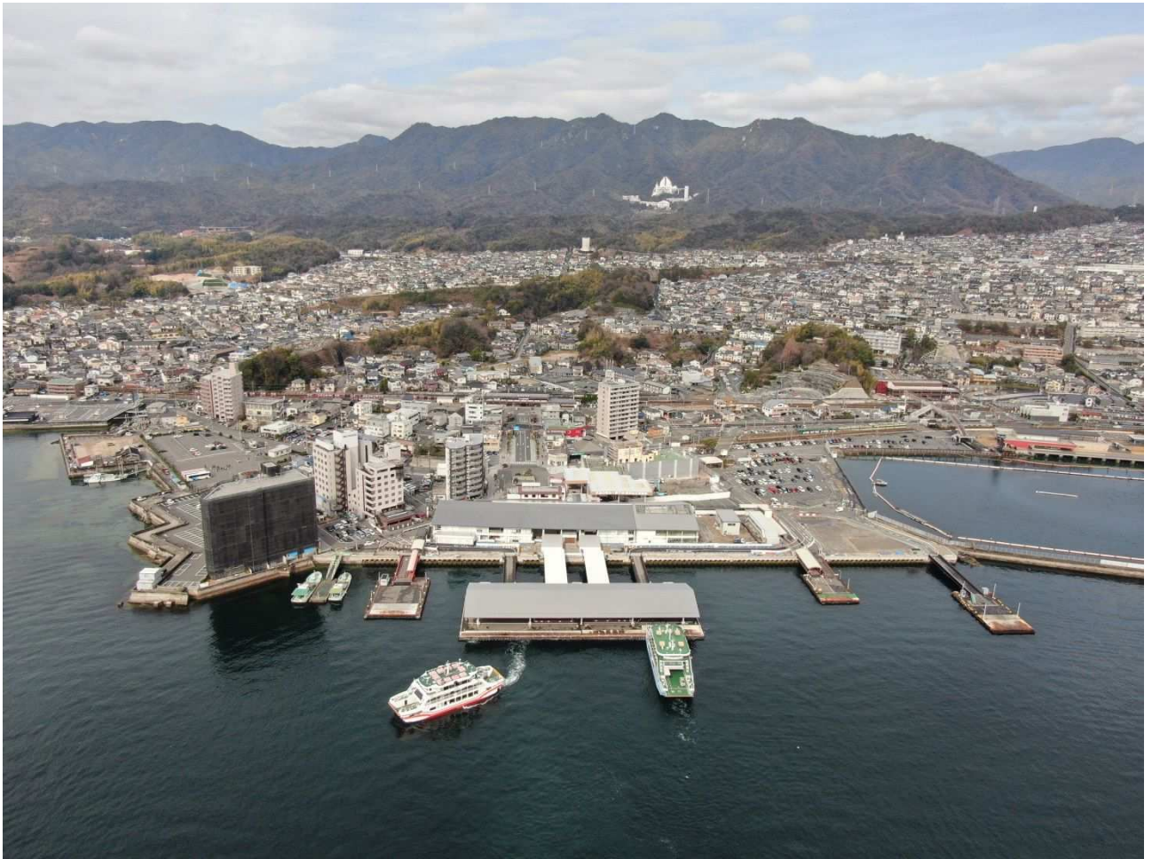
厳島港宮島口旅客ターミナル（R 2.2 供用開始）
