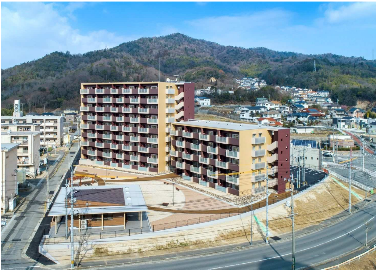
県営熊野住宅整備事業（北ブロック1期工事竣工写真）（安芸郡熊野町）
