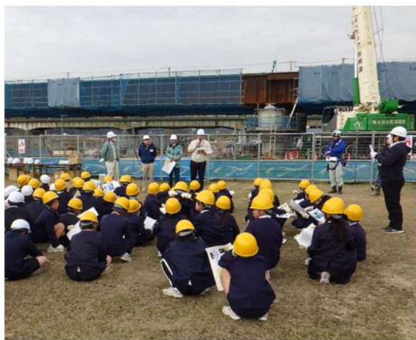
【工事現場見学会（福山沼隈道路）】
