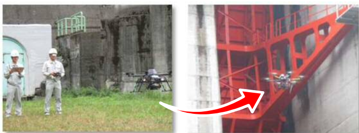
【ドローンを活用した施設点検】
