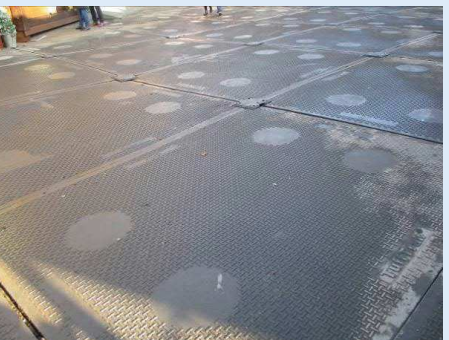
クリスマスマーケット 園内には、歩行空間だけでなく、仮設建物の下にもゴム製の仮設床材が敷き詰められていた。
