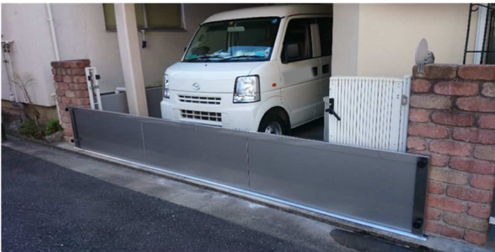
【止水板の設置例】
