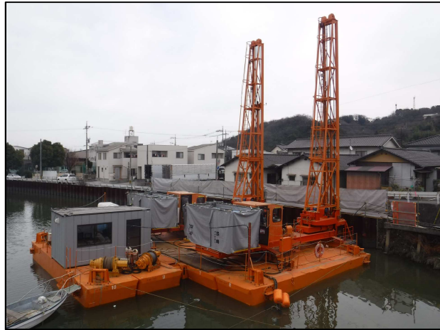
施工状況(地盤改良工事)
