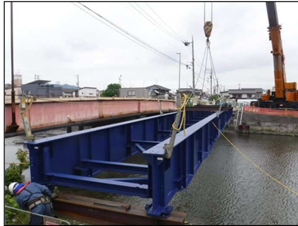
施工状況(仮設歩道橋架設工事(三ツ橋))
