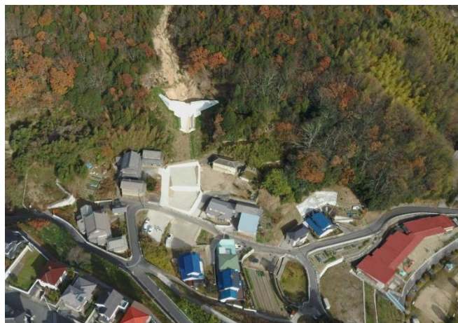
【図4 災害地の復旧状況（福山市神村町）】
