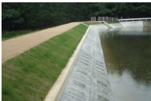
【図2 補強工事（改修）】
