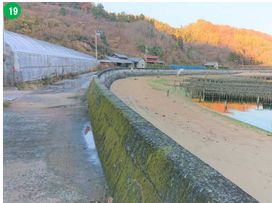
倉橋海岸脇田第2期地区
