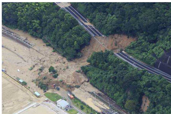
平成30年7月豪雨災害により被災した道路、鉄道及び海岸施設
