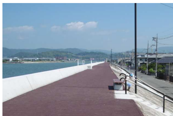
堤防（尾道糸崎港海岸）
