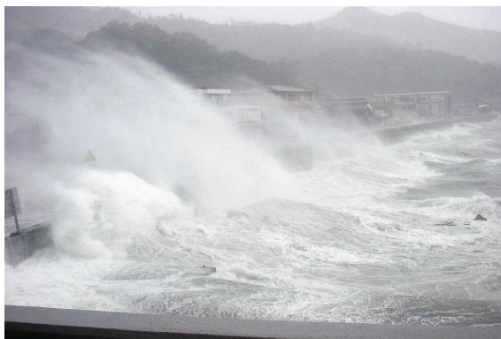
H16 台風 18 号による被害（倉橋漁港海岸）
