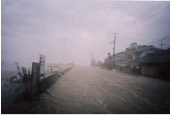
H16 台風 18 号による被害（尾道糸崎港海岸）
