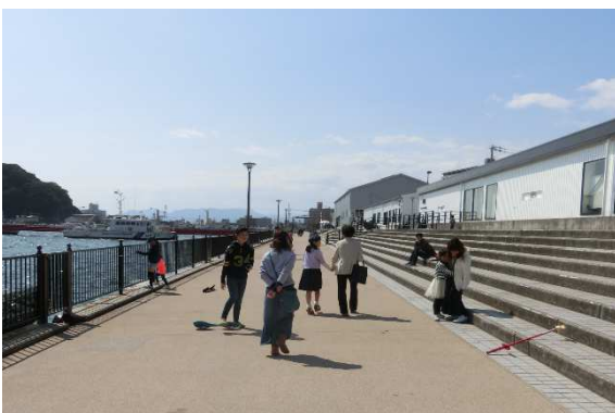
一体的に整備した傾斜護岸（広島港海岸）
