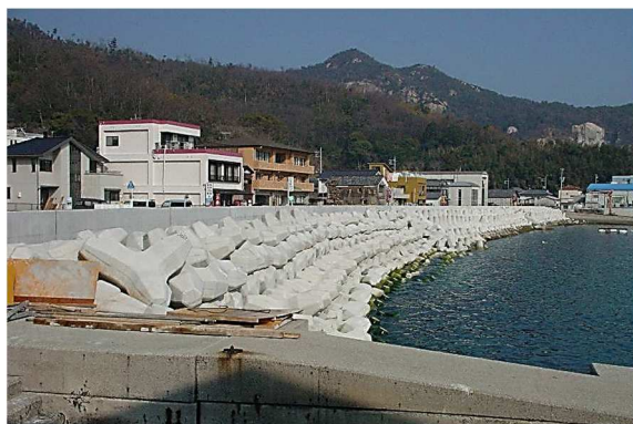
消波ブロック（倉橋漁港海岸）
