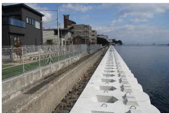
護岸（直立消波式 工事中）（大野海岸早時地区海岸）
