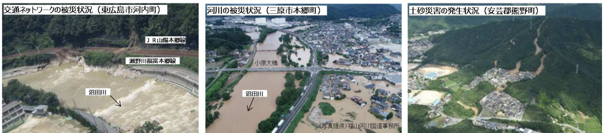
【平成30年7月豪雨における災害発生状況】
