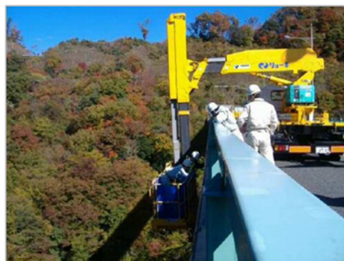
【橋梁点検車による施設点検の実施状況】
