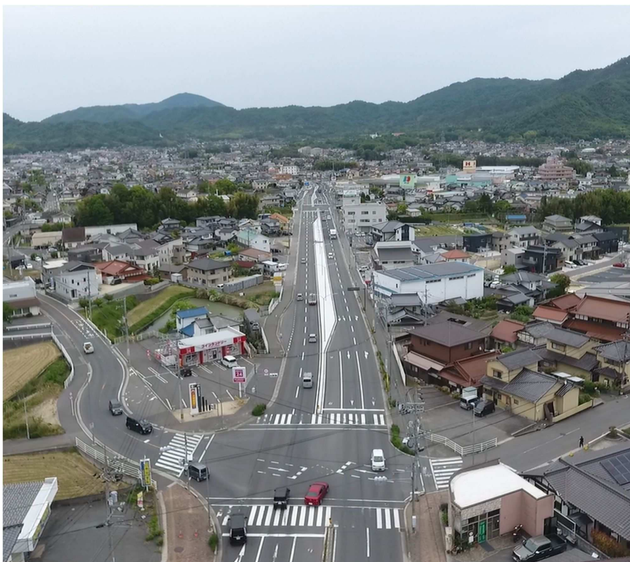
道路改良事業 主要地方道矢野安浦線川角工区（熊野町）
