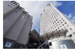
第5位 NTTクレド基町ビル (広島市)
