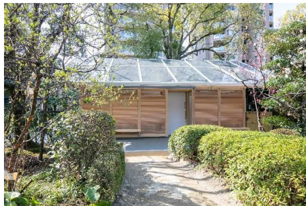
ひろしま建築学生チャレンジコンペ2019対象建築物 (縮景園内事務所棟東トイレ)
