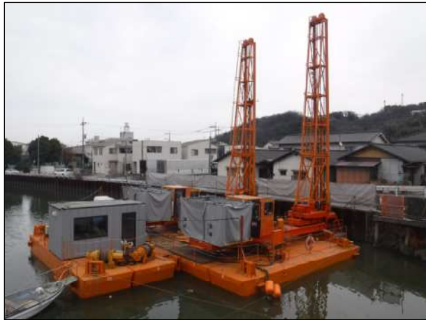
施工状況(地盤改良工事)
