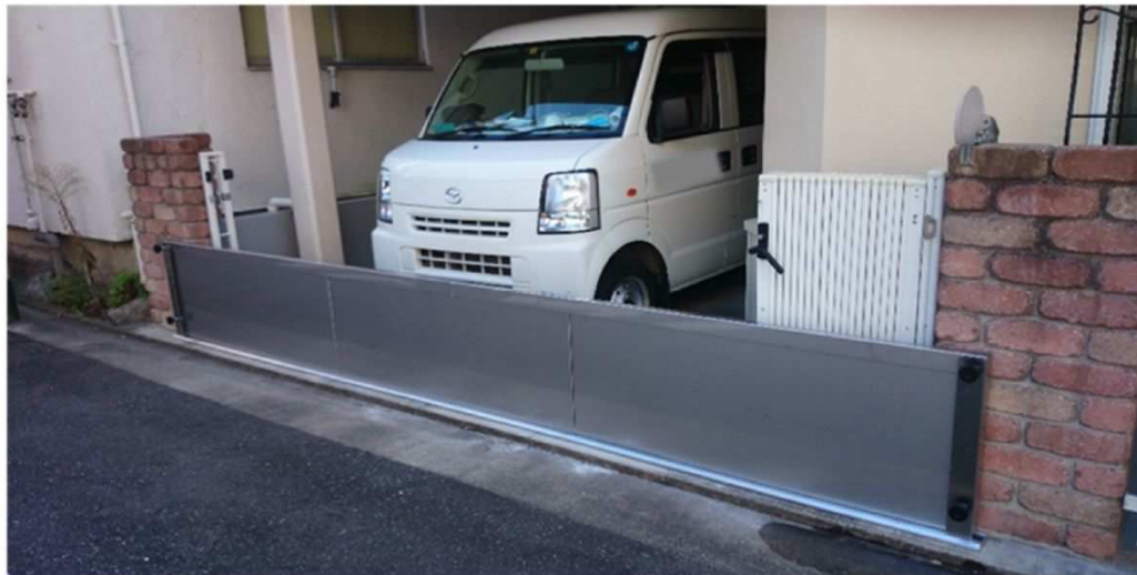
【止水板の設置例】
