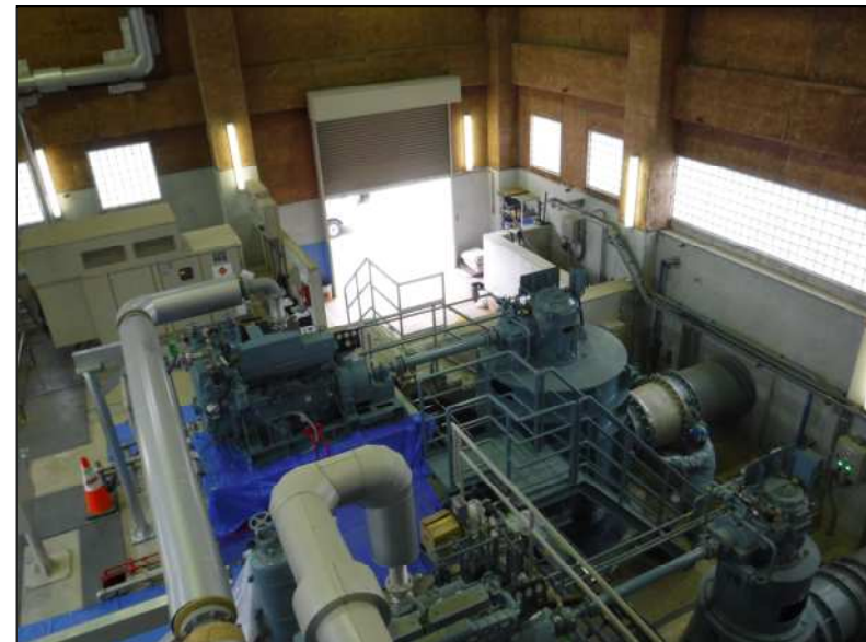
施工状況(3号ポンプ)
