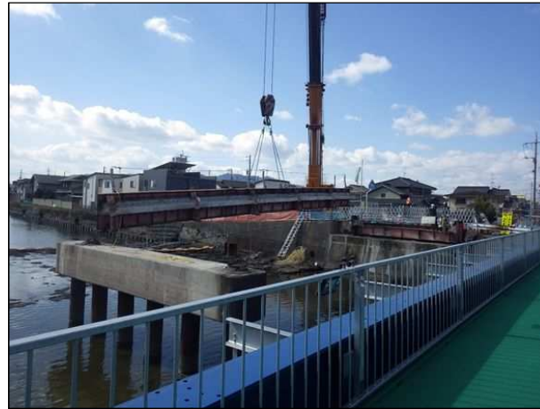
施工状況(三ツ橋撤去工事)
