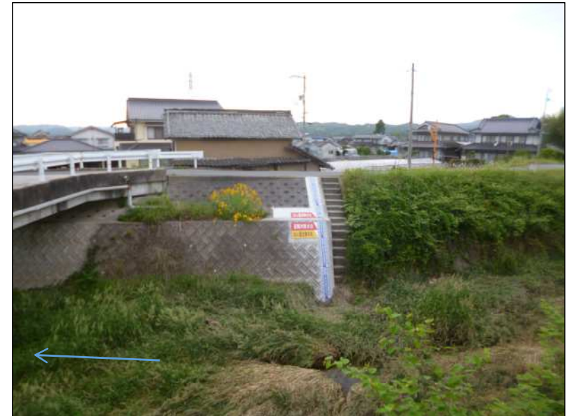
施工状況(0k600付近)
