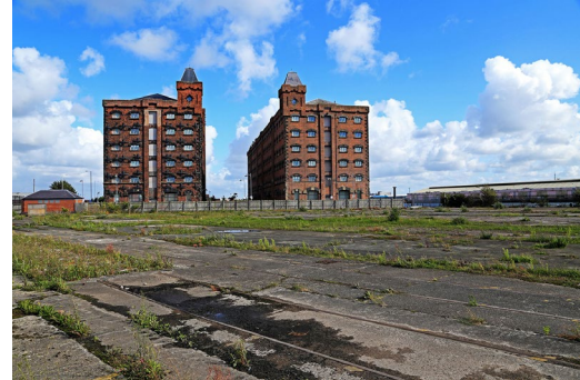
ウォラシー穀物倉庫 (イギリス)
