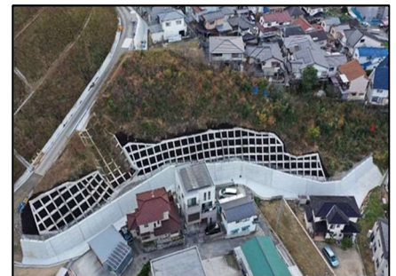
急傾斜地崩壊対策事業 (海田町 南幸町13地区)
