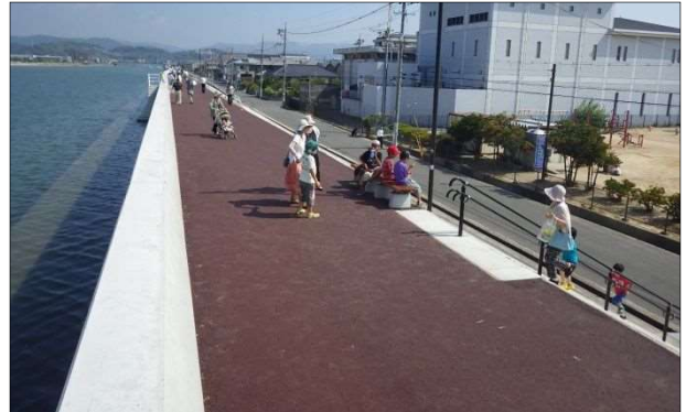
尾道糸崎港海岸堤防
