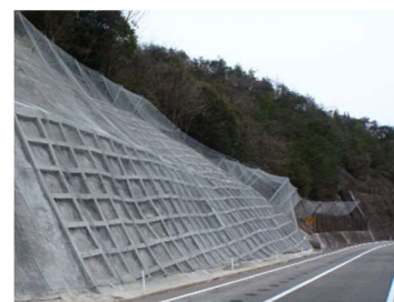
法面对策の実施状況 (東広島市安芸津町)
