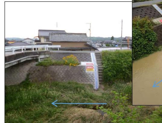
施工状況(0k600付近)
