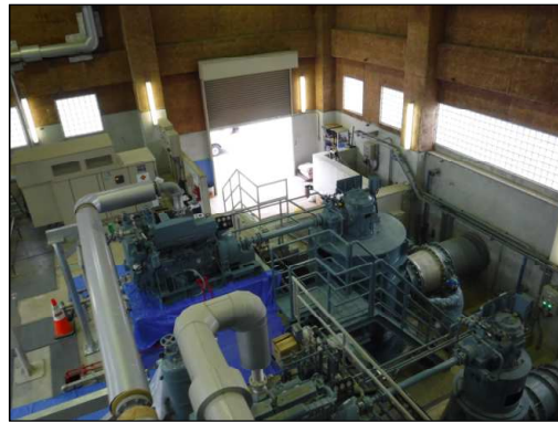
施工状況(3号ポンプ)
