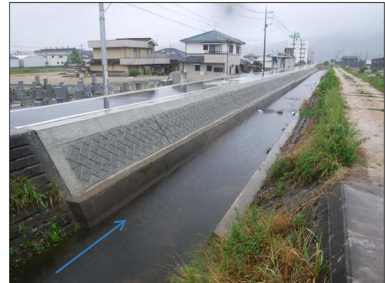
施工状況(ブロック積工)
