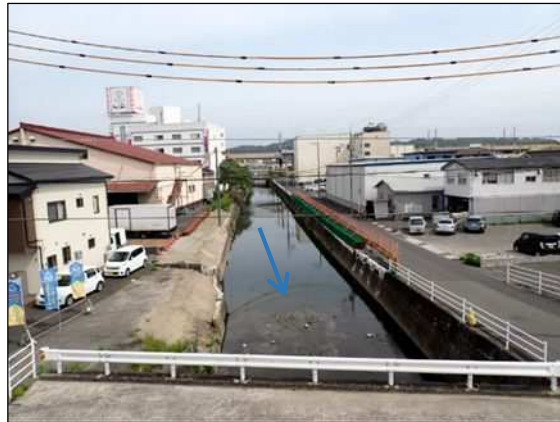
施工状況(下流側)
