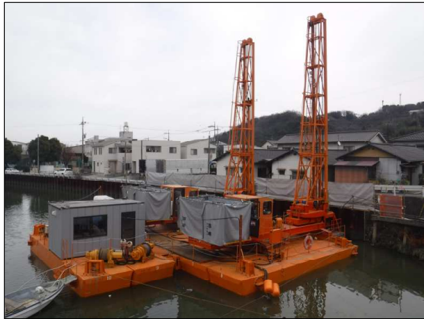
施工状況(地盤改良工事)
