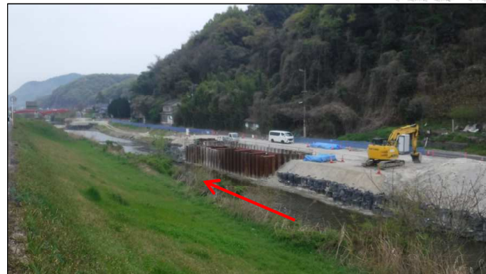
施工状況(サイフォン管移設)
