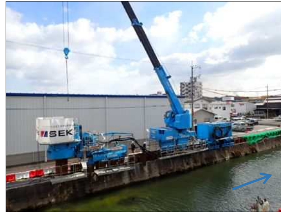
施工状況(打設)
