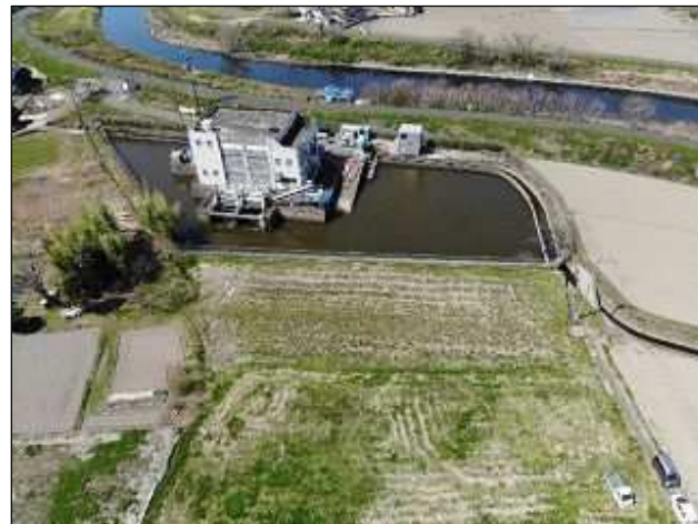
着工前(調整池)
