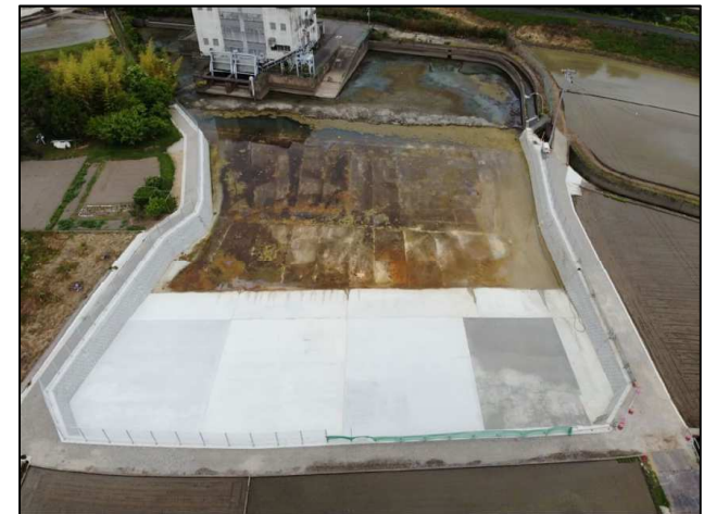
着工後(調整池)
