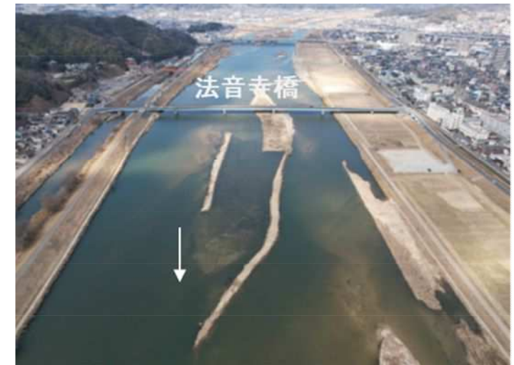
【着工後(令和4年3月末撮影)】
