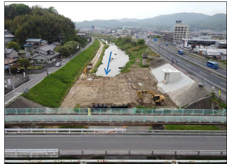
施工状況(吐出樋門)
