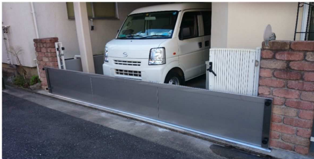
【止水板の設置例】
