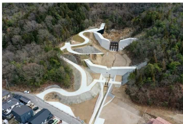
熊野町川角地区における平成30年7月豪雨に対する土砂災害対策の完成
