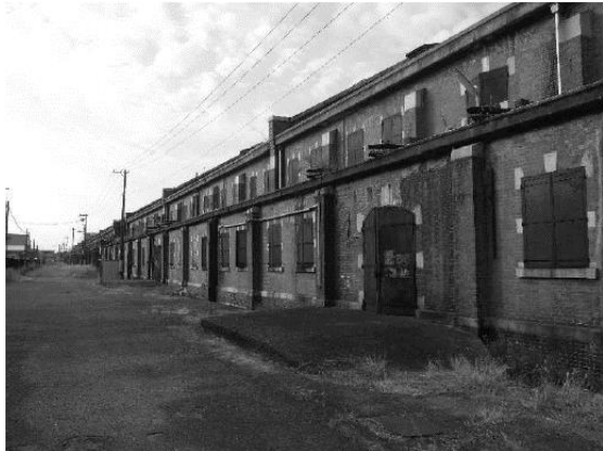
(1号棟前面 運送車両用プラットフォーム)
