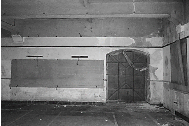
(2号棟2階 黒板跡、漆喰壁など)
