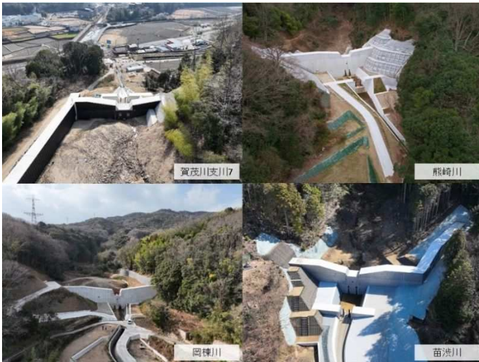
激特事業完成箇所
