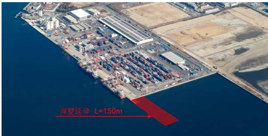
広島港出島地区国際海上コンテナターミナル整備事業着工
