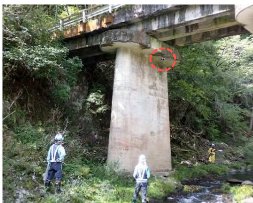
ドローンによる橋梁点検の実施
