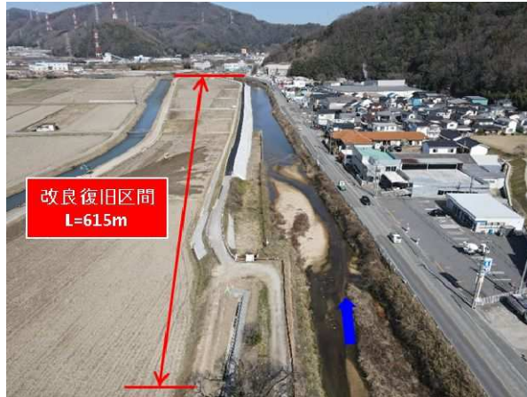
二級河川沼田川水系天井川における改良復旧の完了
