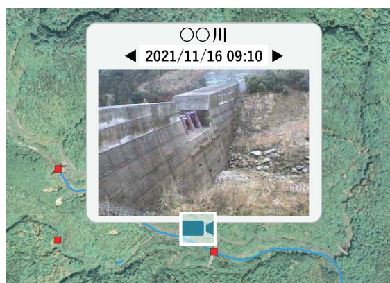
監視カメラの撮影画像表示イメージ
