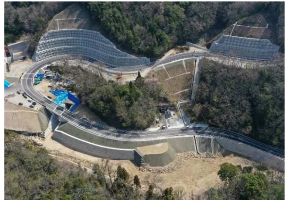
呉環状線災害関連事業完了
