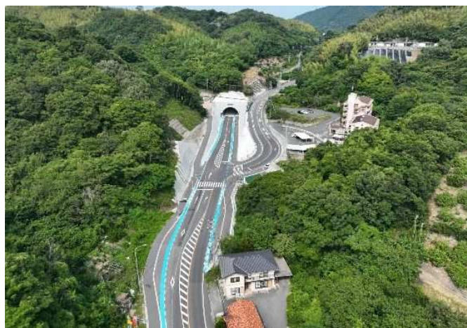
一般国道317号（新青影トンネル）供用開始
