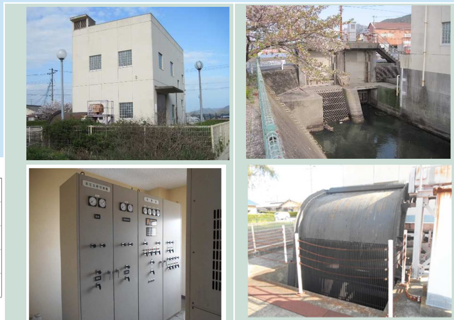
沢排水機場(尾道市瀬戸田町中野)
