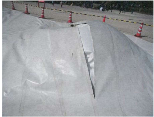
使用禁止措置（近景）
