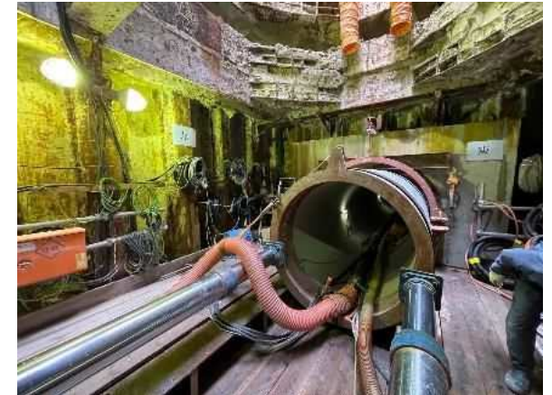
施工状況(φ1500推進工)
