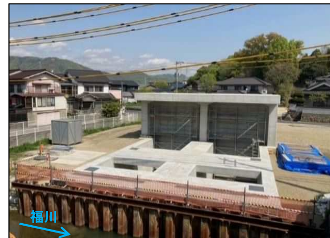
施工状況(福川排水機場(仮称))
