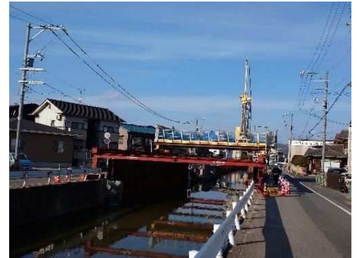
施工状況(地盤改良工事)
