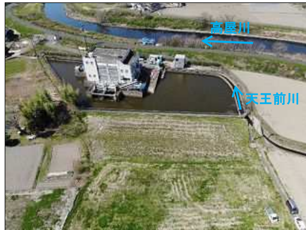
着工前(調整池)
