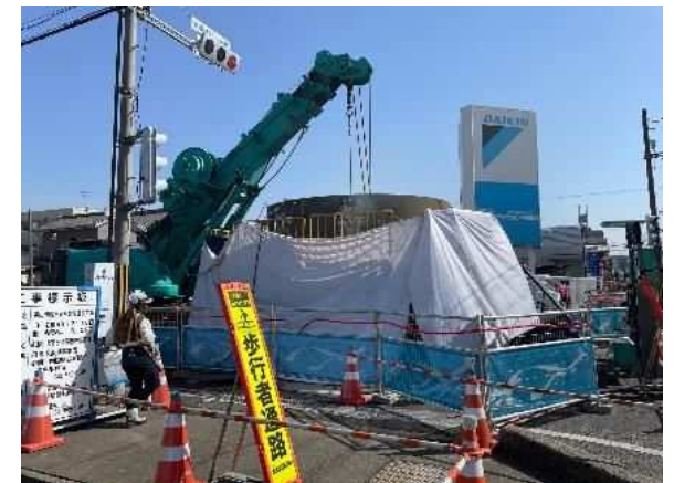
施工状況(立坑工)
