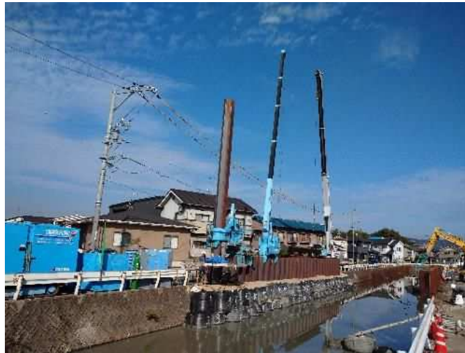
施工状況(鋼矢板護岸工事)
