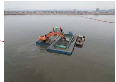
施工状況(令和4年8月)
