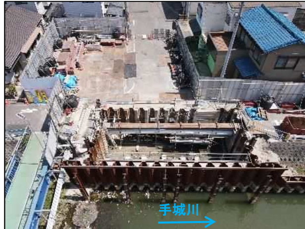
施工状況(橋台(左岸))
