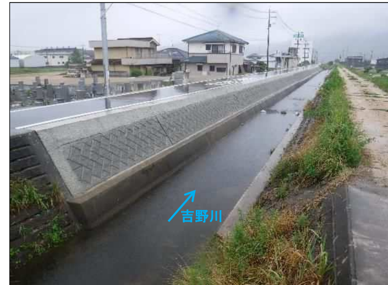
施工状況(ブロック積工)
