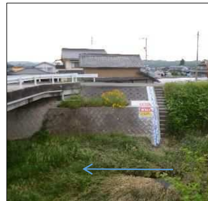
施工状況(0k600付近)
