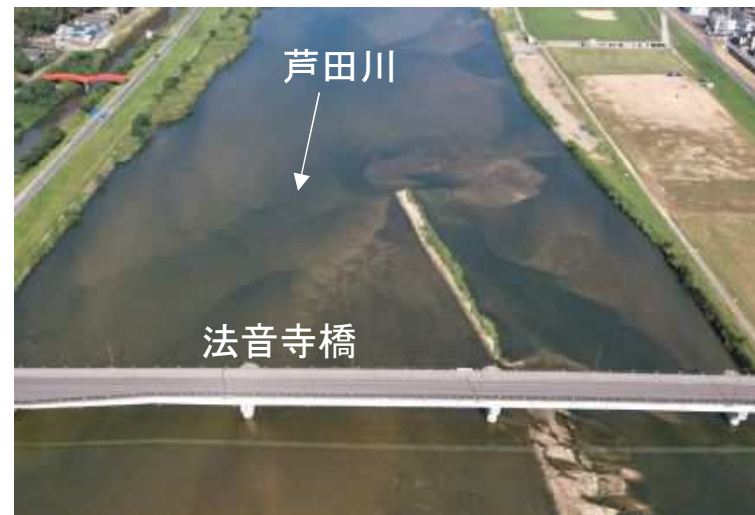
【着工後(令和4年9月末撮影)】
