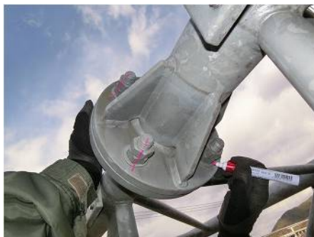
図 V-1 合いマーク施工状況
