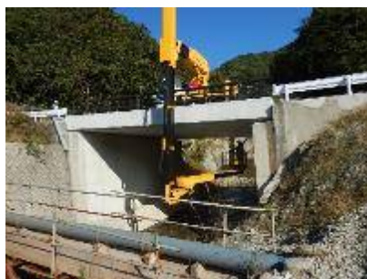
橋梁点検車による点検（委託）
