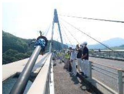
斜張橋のロボットによる点検
