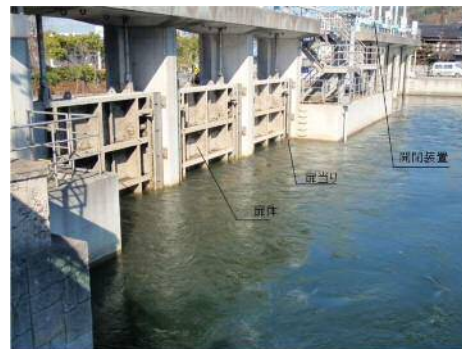
【吐出樋門(手城川排水機場)】
