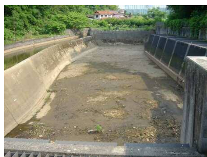
【呑口施設 片丘川放水路】
