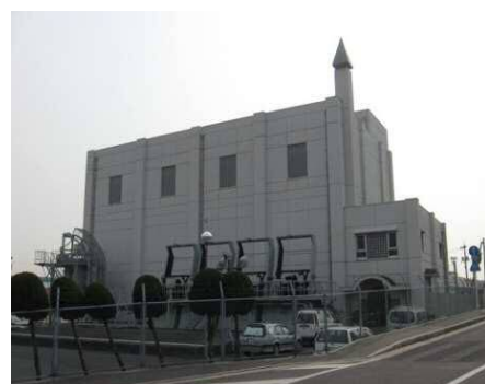
【岡ノ下川排水機場】
