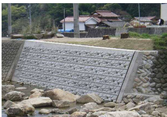
対策区分E ブロック積による修繕
