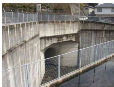
【河川トンネル 八幡川放水路】
