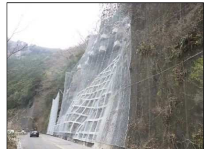
法面对策の実施状況 (山県郡安芸太田町)
