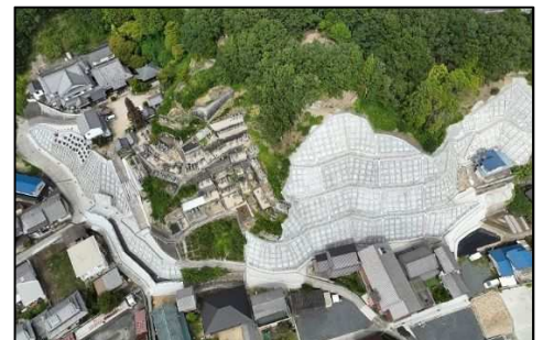
急傾斜地崩壊対策事業 (府中市 広谷地区)
