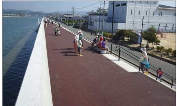
尾道糸崎港海岸堤防
