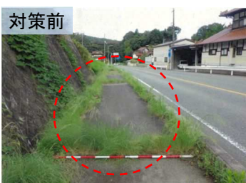
【歩道の防草対策(舗装修繕)】
