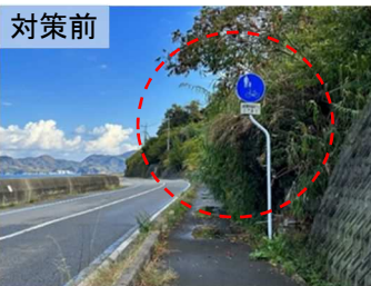
【道路法面の伐木】
