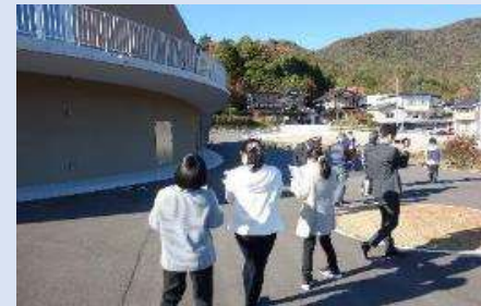
施設の安全確認
