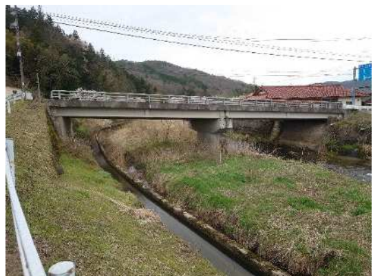
(主) 吉田邑南線 新天神橋 安芸高田市美土里町
