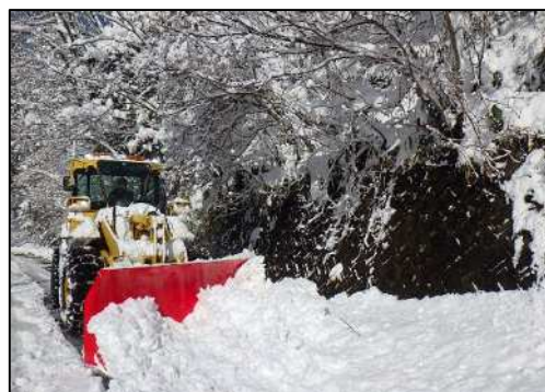
道路除雪状況
