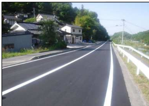
道路舗装補修状況
