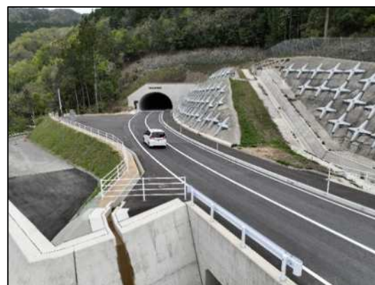
鳴瀬清流トンネル開通状況
