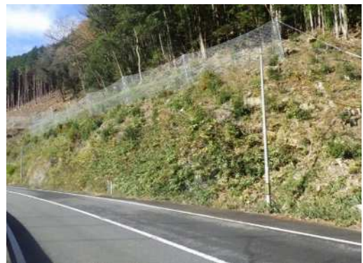
一般県道北船木線 安芸高田市高宮町
