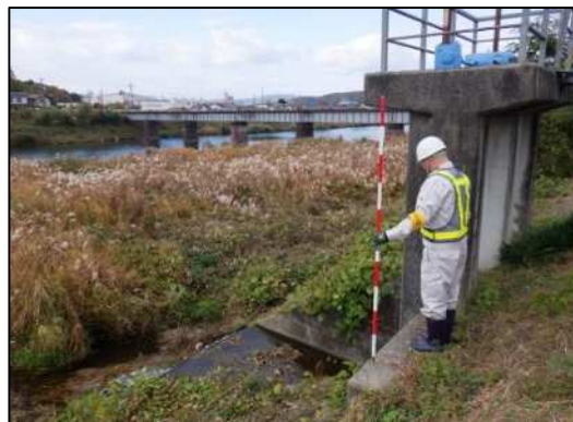
河川樋門点検状況
