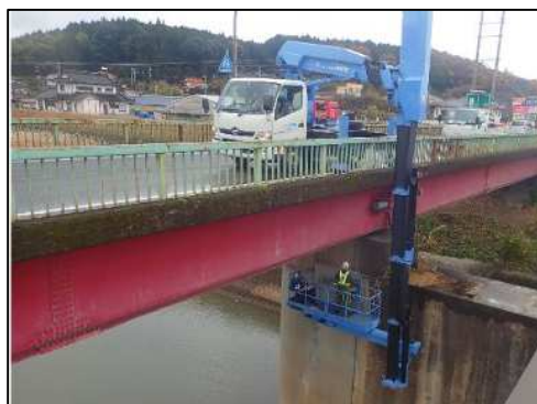
橋梁点検状況
