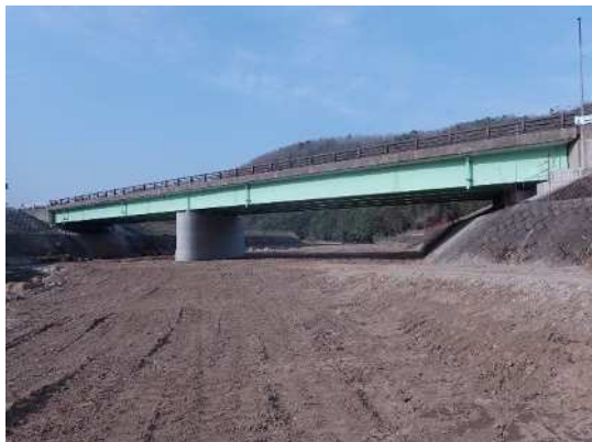
一般国道375号石原橋 三次市石原町
