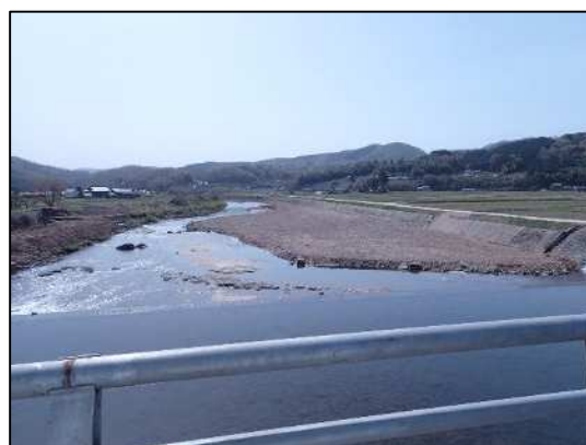
河川浚渫状況
