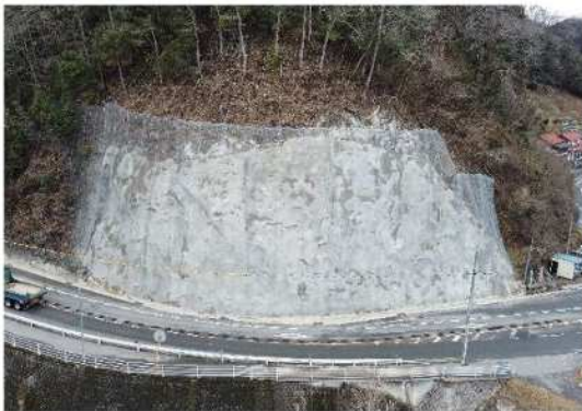
主要地方道三次高野線 三次市三次町
