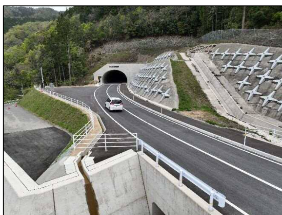
鳴瀬清流トンネル開通状況
