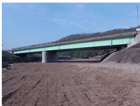
一般国道375号石原橋 三次市石原町 耐震補強工事
