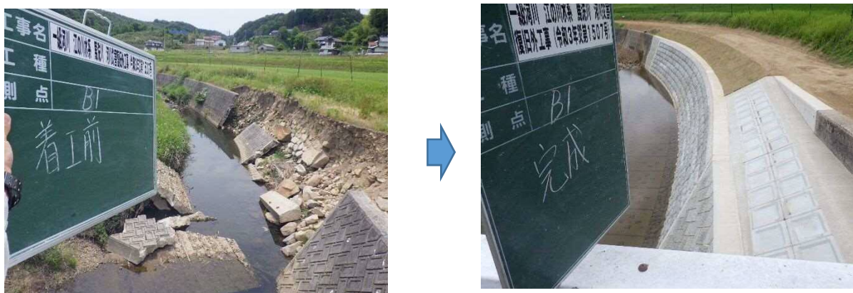
一級河川馬洗川 三次市吉舎町徳市（左：被災状況、右：完成）
