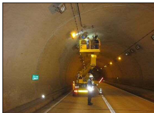
トンネル点検状況
