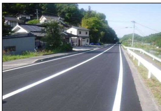
道路舗装補修状況
