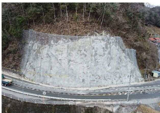
主要地方道三次高野線 三次市三次町 法面防災工事
