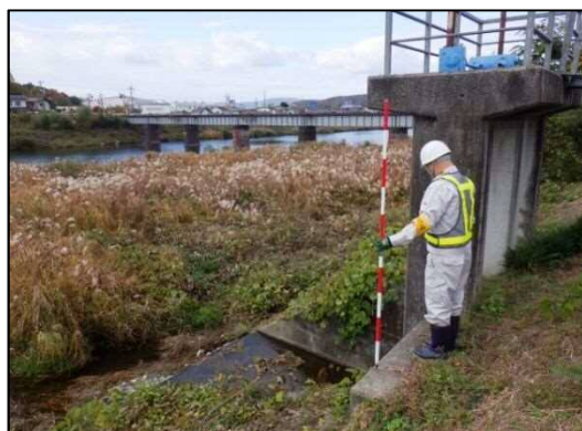
河川樋門点検状況
