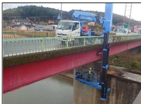
橋梁点検状況
