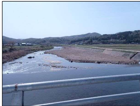
河川浚渫状況
