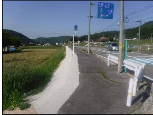
防草対策実施状況
