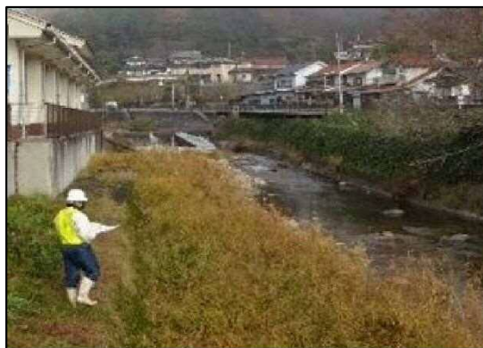
河川巡視状況
