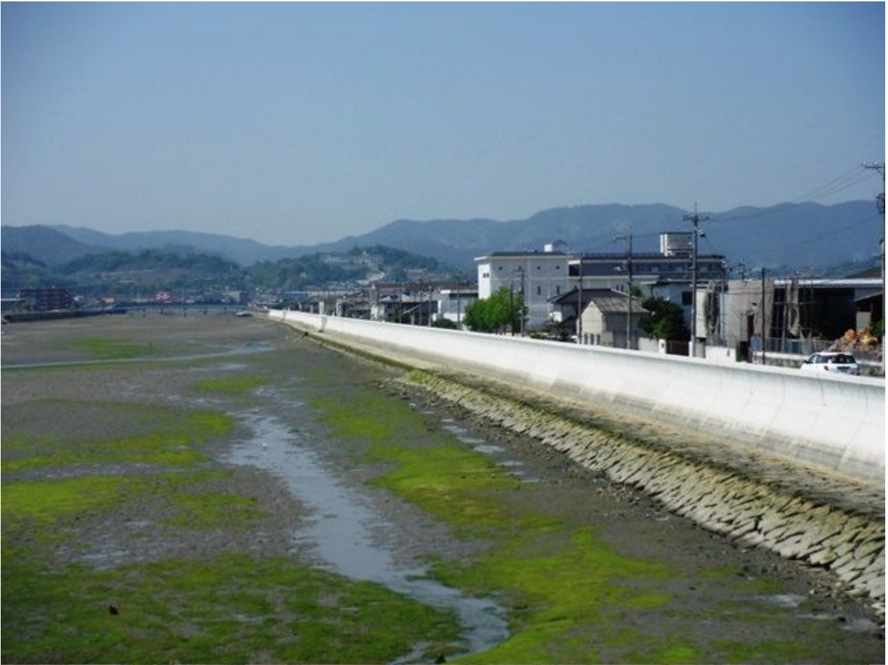
港湾海岸保全施設整備事業 尾道糸崎港海岸機織地区（福山市）
