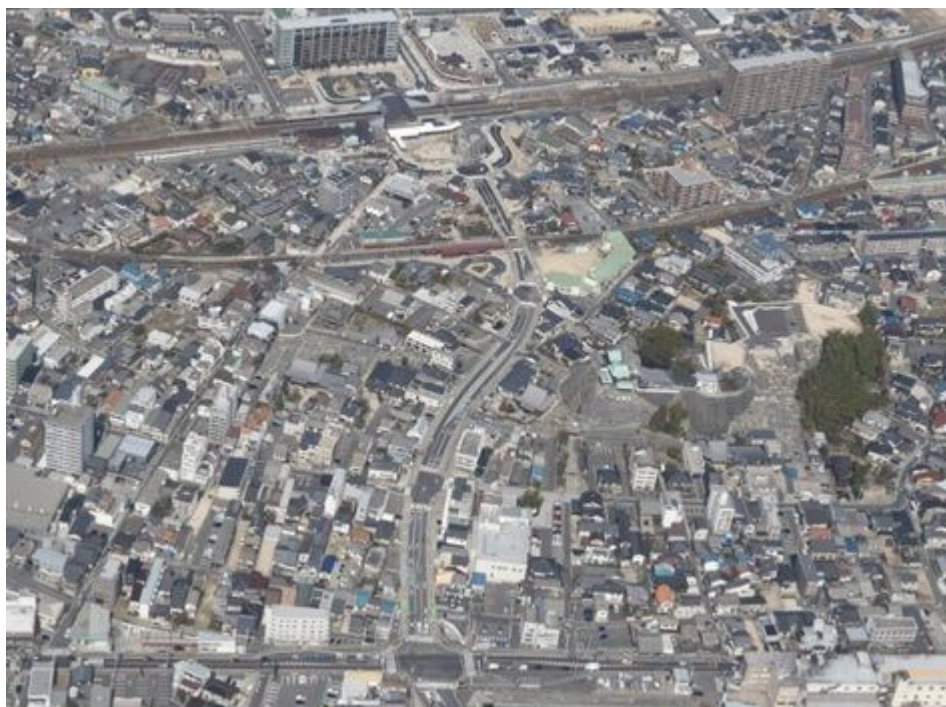
(都) 廿日市駅通線 全線開通 (廿日市市)
