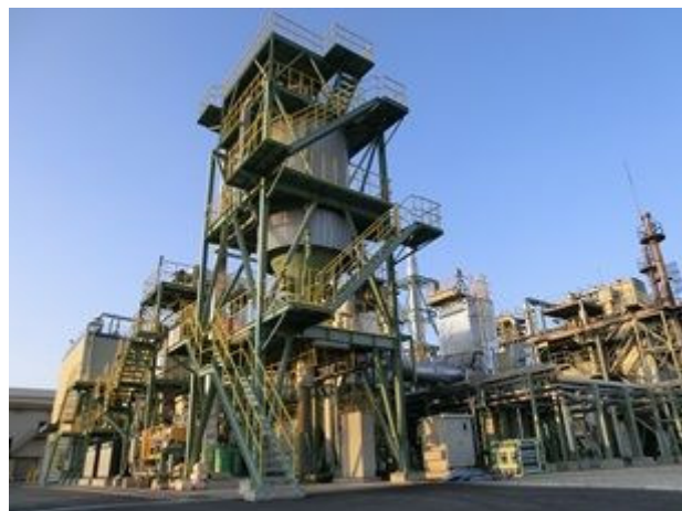
燃料化施設 (平成 29 年 1 月 供用開始)
