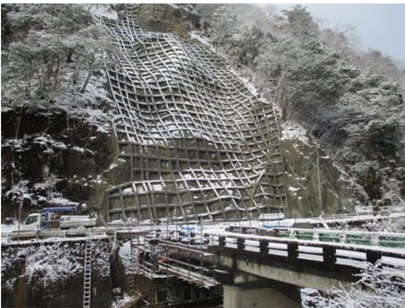
平成29年発生災害 一般国道186号 道路災害復旧工事 (山県郡北広島町細見)
