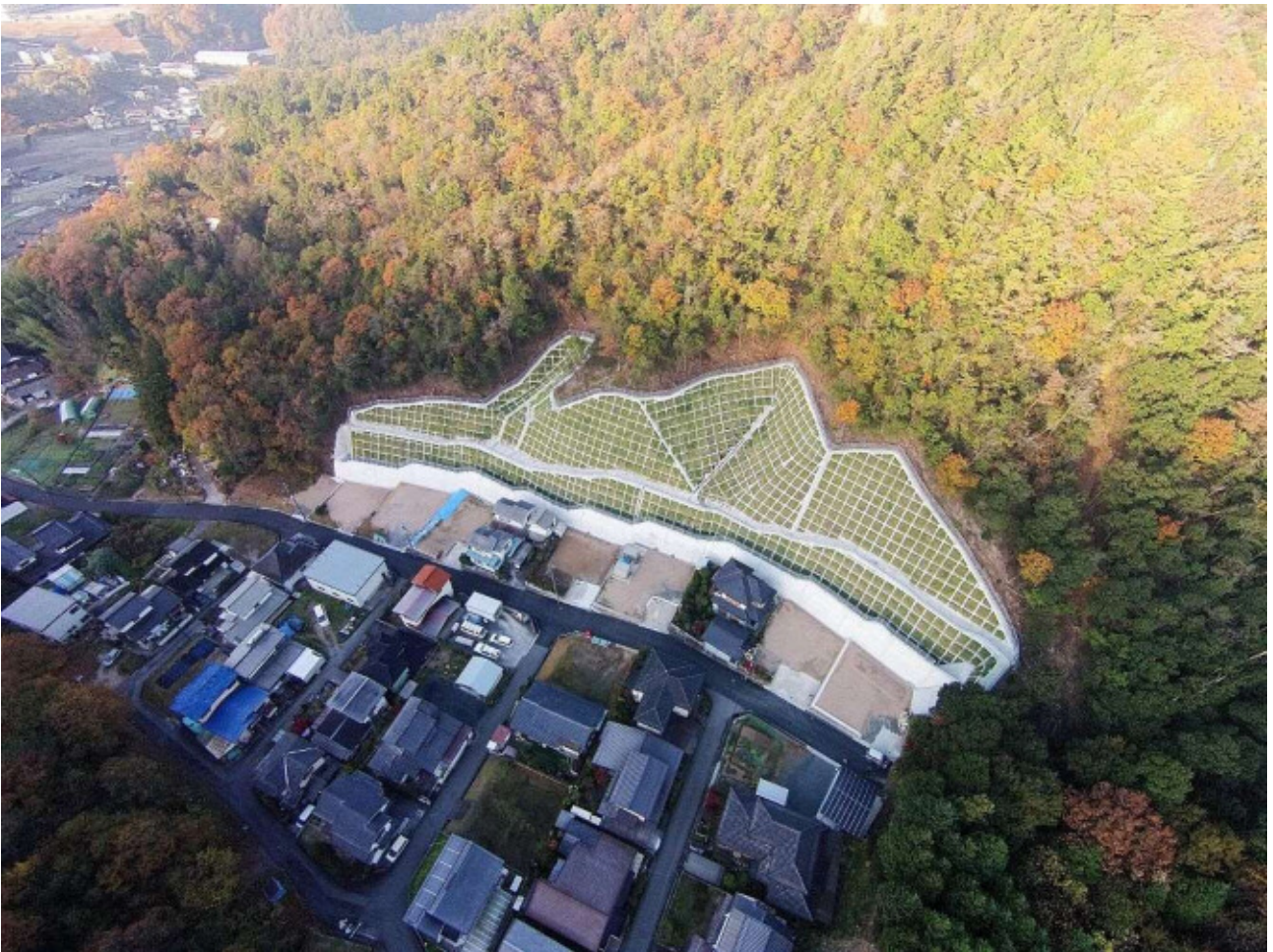
災害関連緊急急傾斜地崩壊対策事業（広島市安佐北区）
