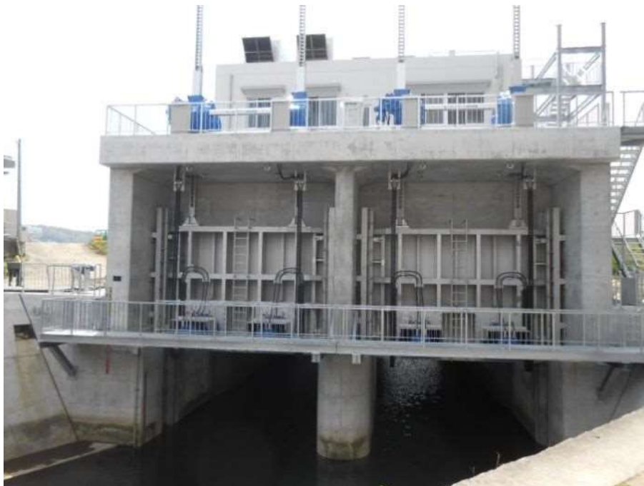
総合流域防災事業 一級河川太田川水系 新安川(広島市)
