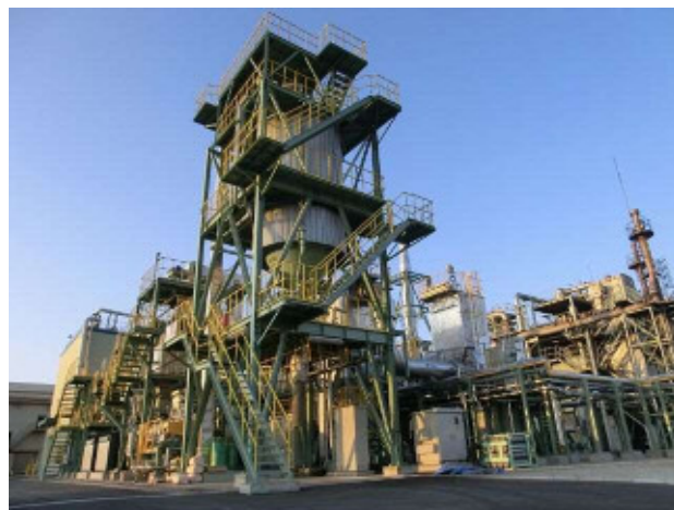
燃料化施設 (平成 29 年 1 月 供用開始)
