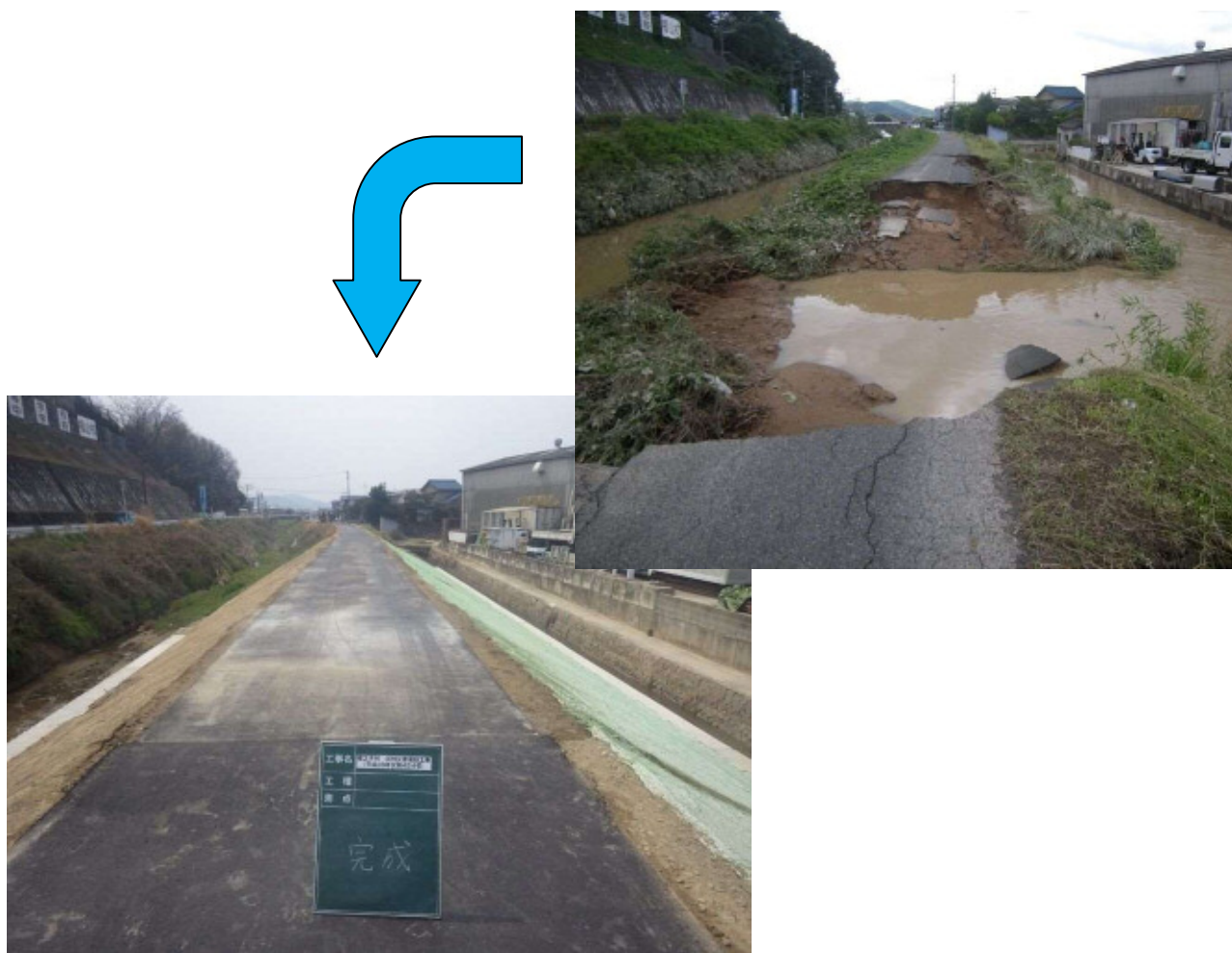
平成 2 8 年発生災害 一級河川芦田川水系猪之子川 河川災害復旧工事 (福山市瀬戸町)
