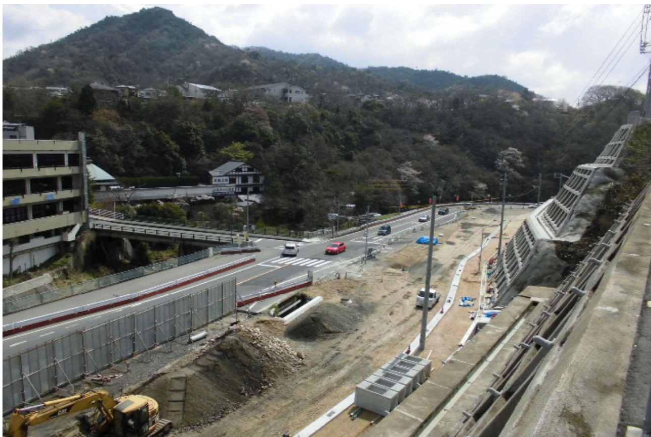
主要地方道呉平谷線 道路改良事業（呉市焼山ひばりヶ丘町）
