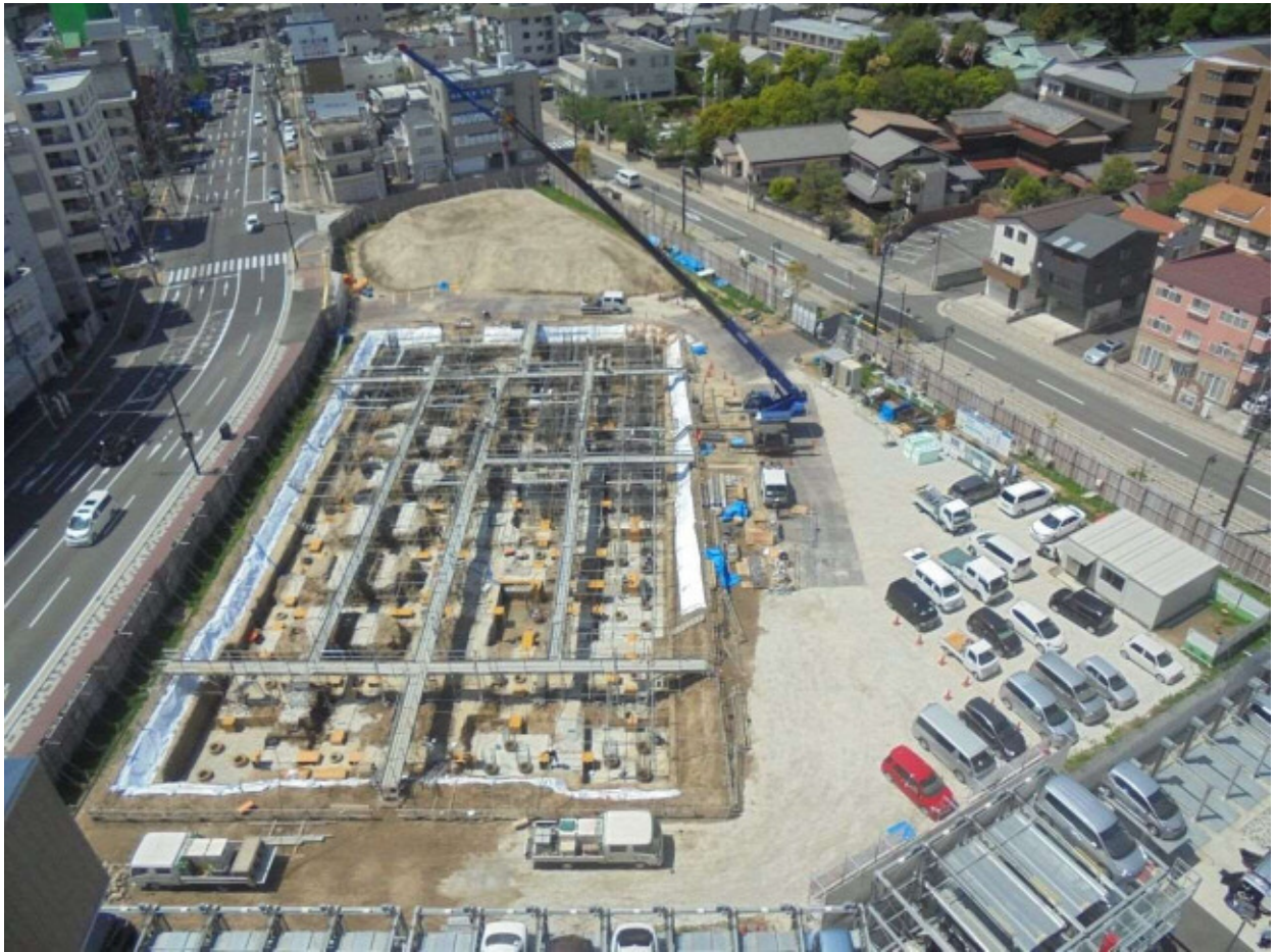
広島東警察署庁舎新築工事
