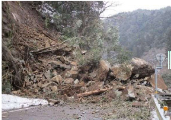
一般国道186号（北広島町細見）被災状況 H29. 2. 1
