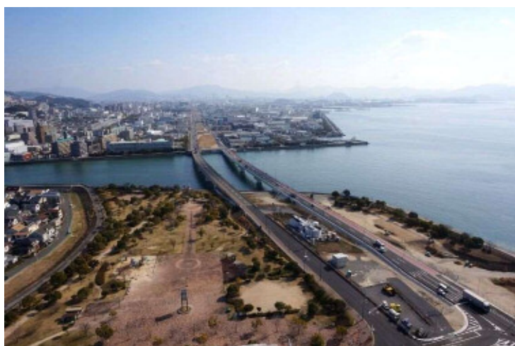
臨港道路廿日市草津線（I期）4車線化事業開通 H29. 2. 19
