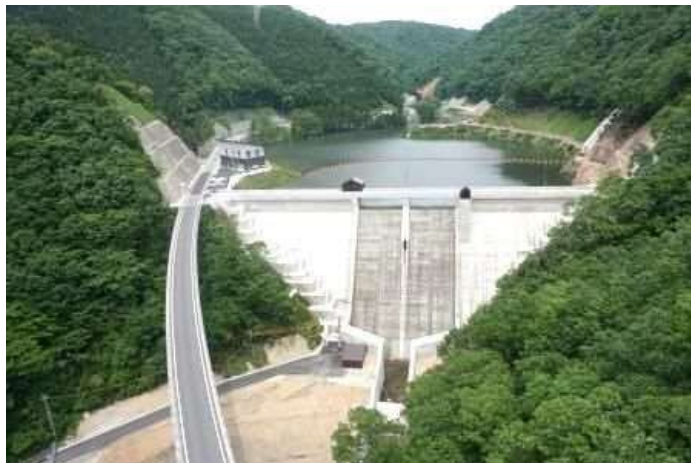
庄原ダム 試験湛水にてサーチャージ水位へ到達 H28. 5. 18
