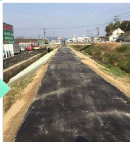
猪之子川（左岸）復旧 H29. 3. 16
