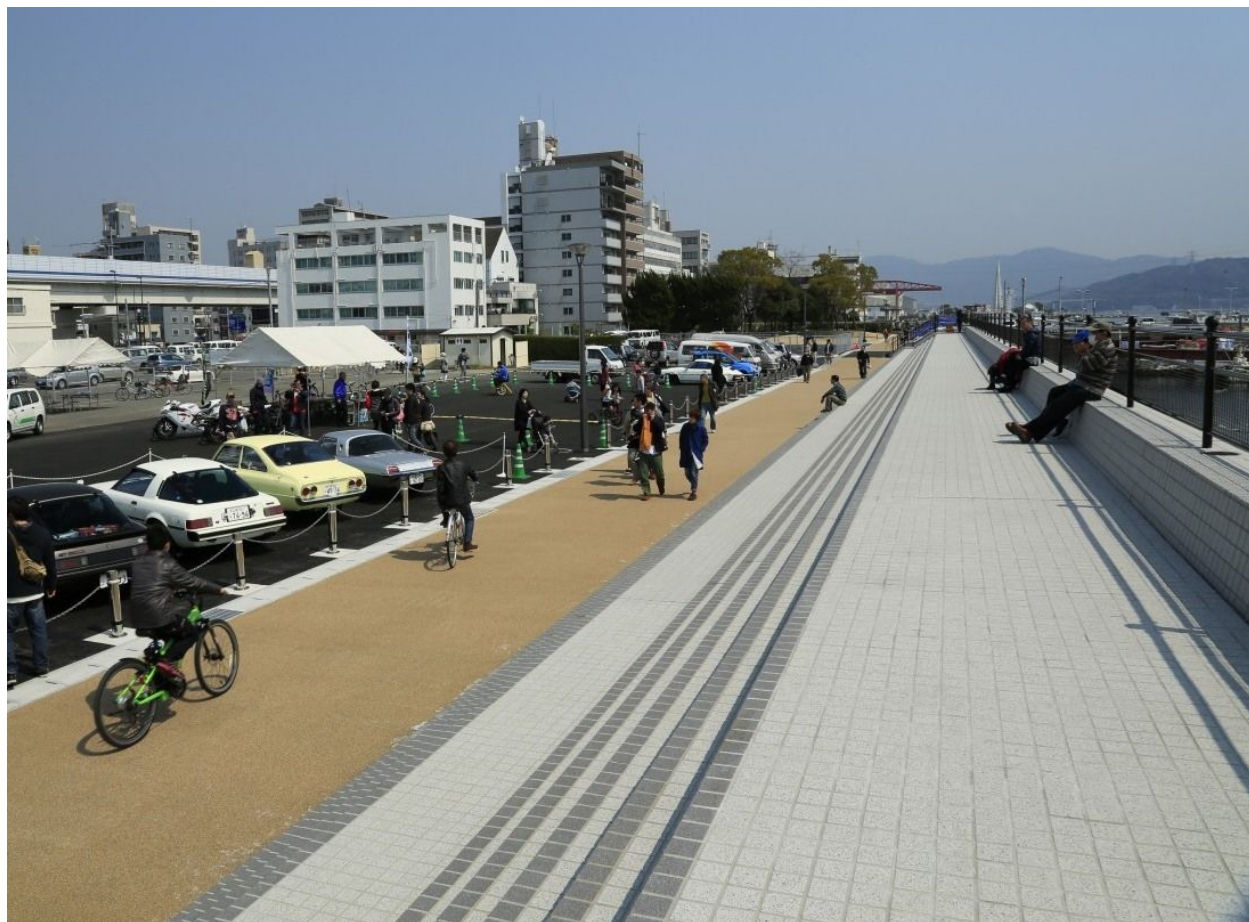
港湾海岸保全施設整備事業 広島港海岸宇品地区（広島市）
