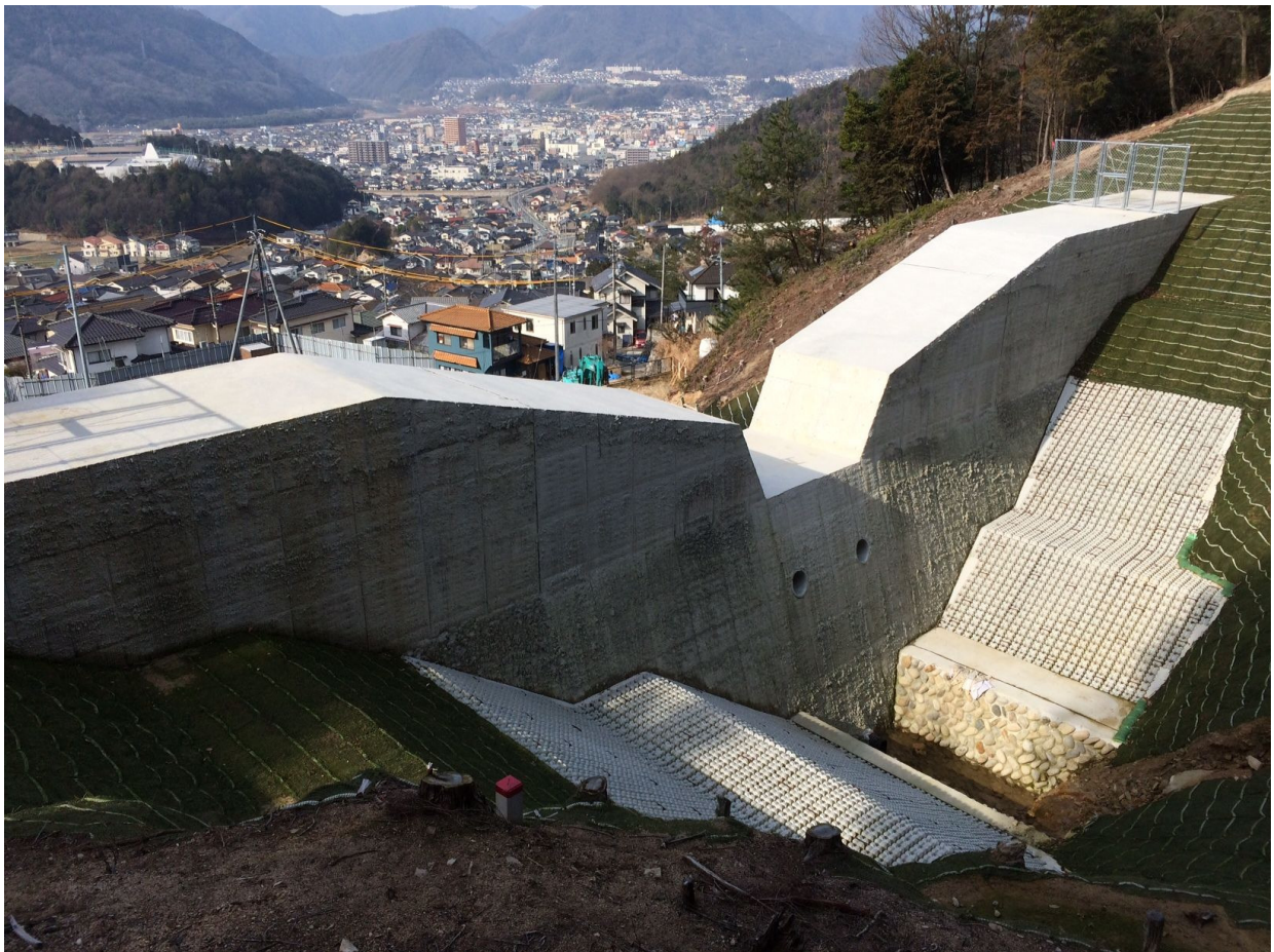
災害関連緊急砂防事業（広島市安佐北区）
