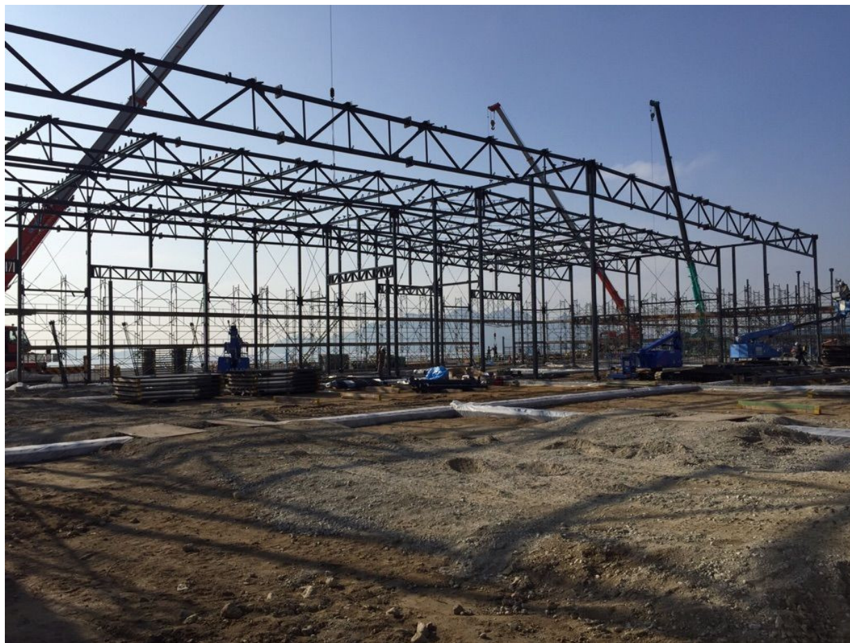
広島港五日市地区五日市2号県営上屋新築工事
