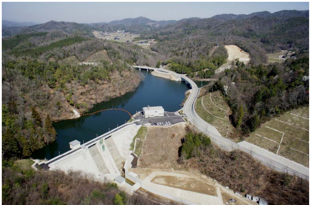
野間川ダム全景 (三原市・尾道市)
