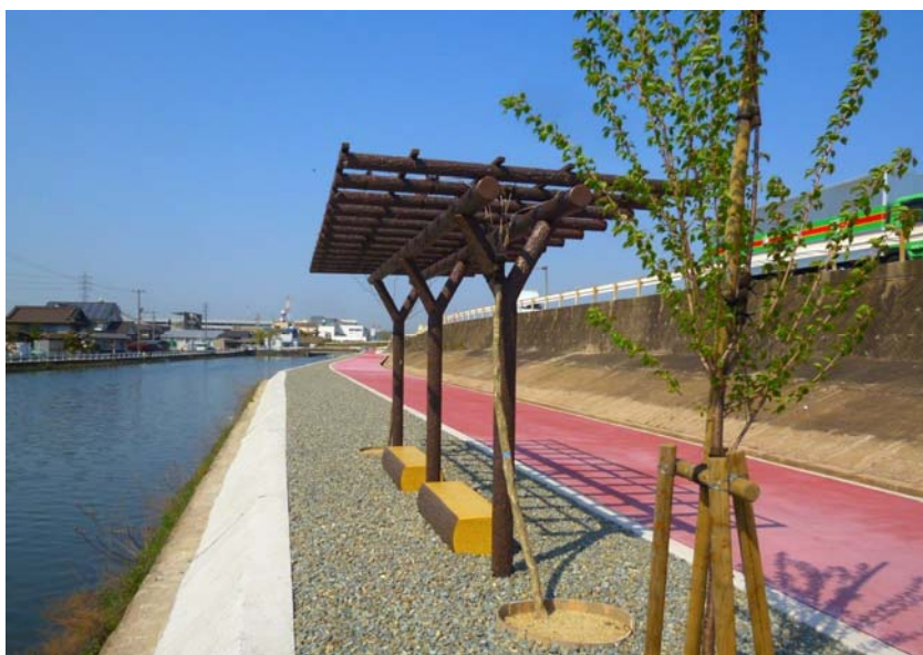
港湾海岸保全施設整備事業 福山港一文字地区（福山市）
