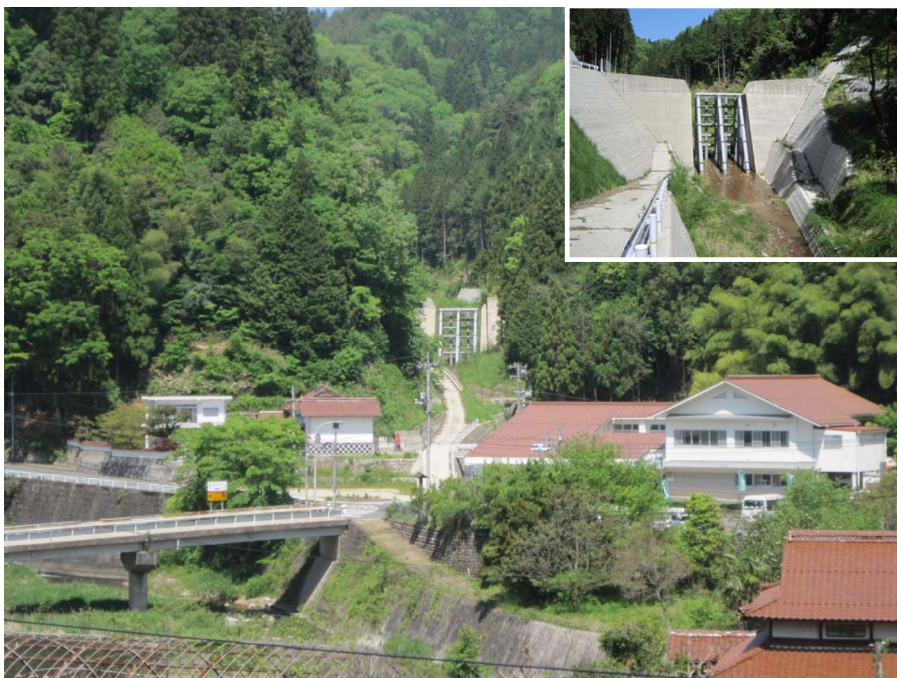
通常砂防事業（山県郡安芸太田町 市小谷川）
