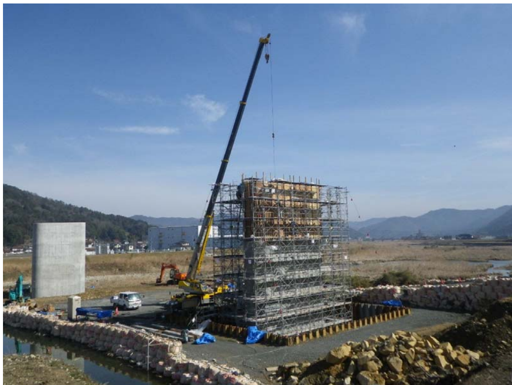
東広島高田道路（主要地方道吉田豊栄線）道路改良工事（安芸高田市吉田町国司）
