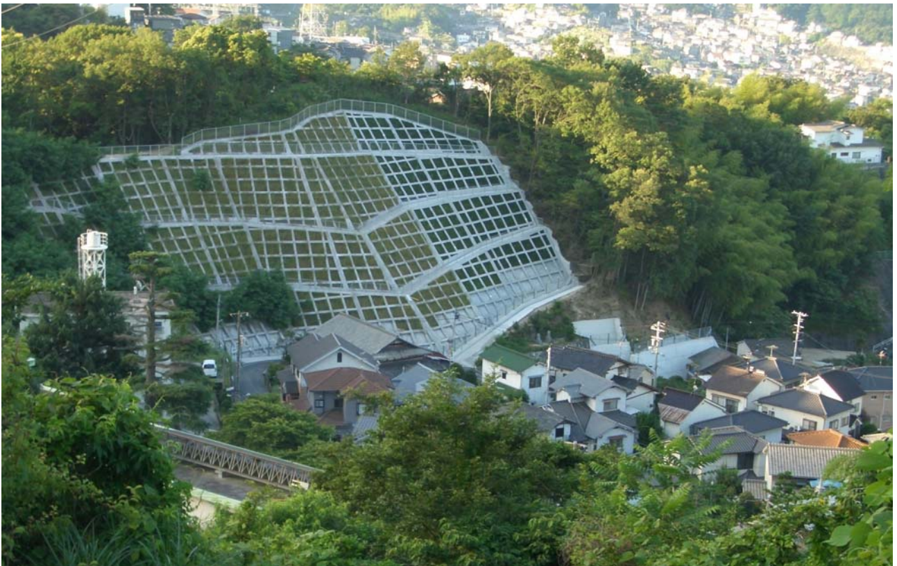
急傾斜地崩壊対策事業（呉市西谷町 西谷町 7 地区）
