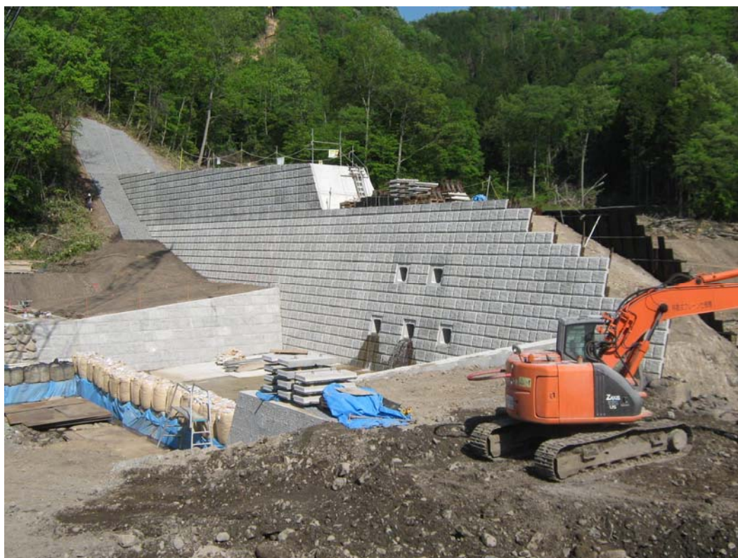
砂防激甚災害対策特別緊急工事（5工区）篠堂川支川堰堤（庄原市川北町）
