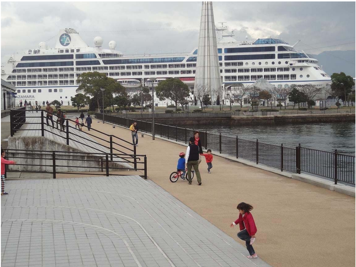
港湾海岸保全施設整備事業 広島港宇品地区（広島市）
