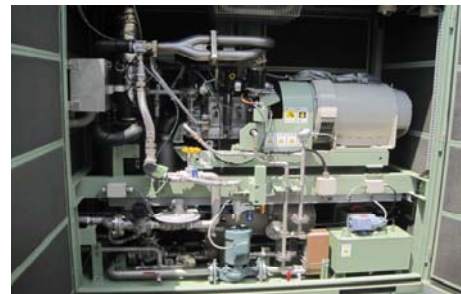
「ロータリーエンジン」消化ガス発電システム 太田川流域下水道 東部浄化センター
