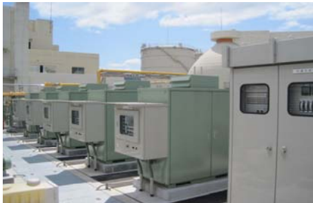
「ロータリーエンジン」消化ガス発電システム 太田川流域下水道 東部浄化センター
