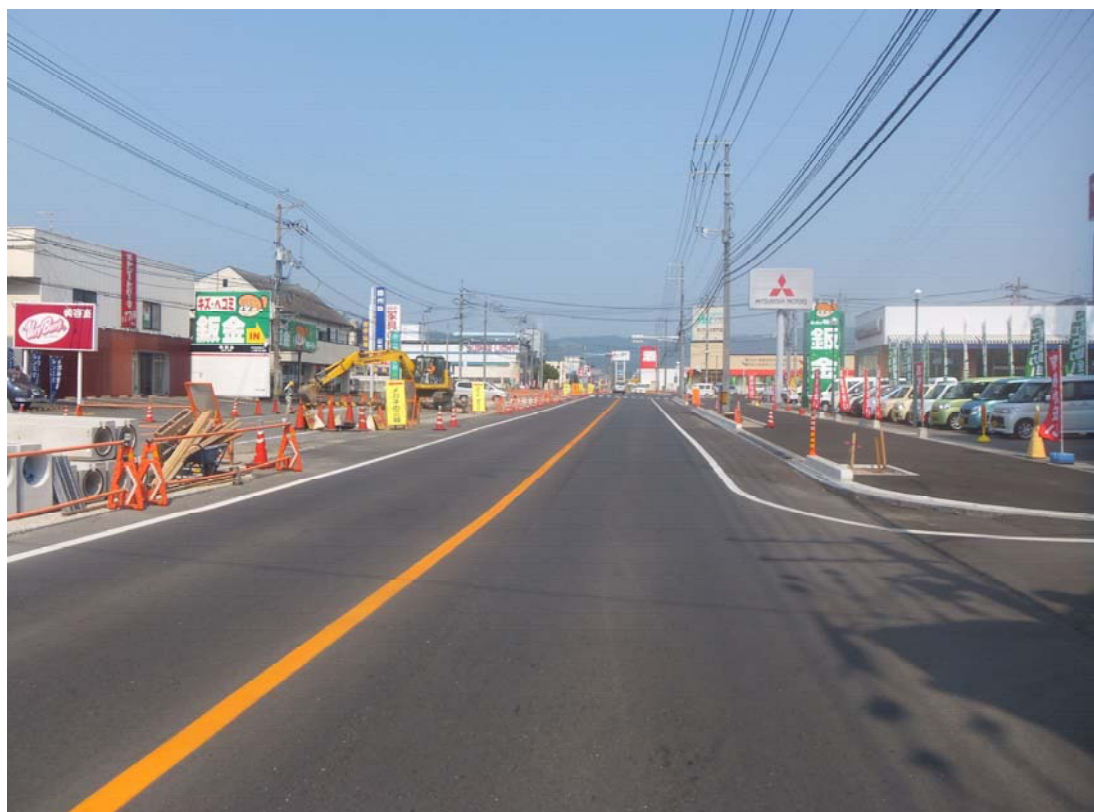
一般国道486号 道路改良事業（府中市中須町）
