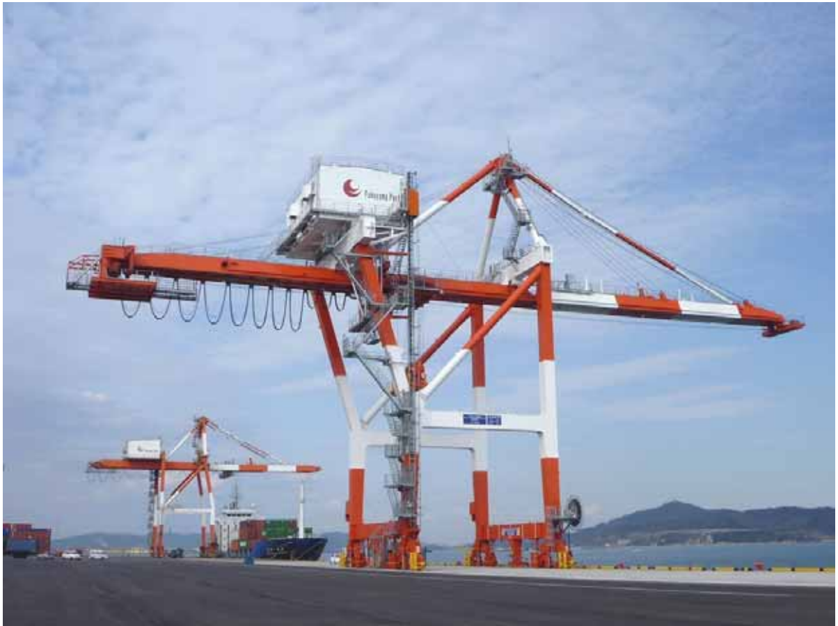
福山港国際コンテナターミナル
