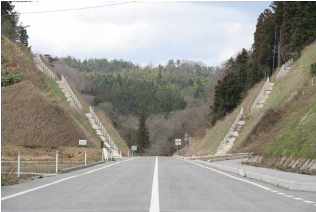
(主) 甲田作木線 道路改良事業 (安芸高田市高宮町川根)
