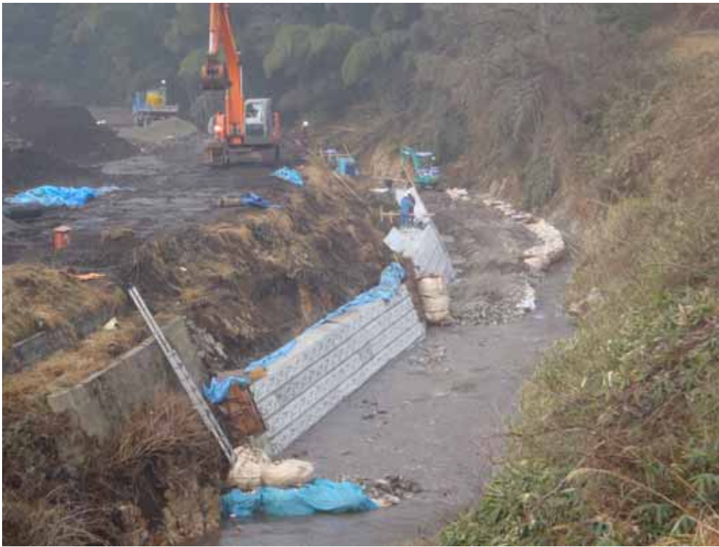
一級河川 大津恵川 災害復旧工事 (庄原市川北町)
