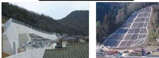
待受擁壁工, 法枠工
