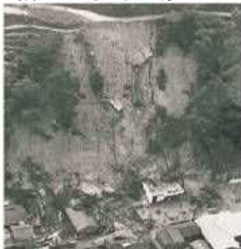
▲呉市で発生したかけ崩れ
