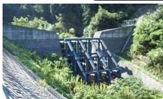
砂防堰堤(透過型)
