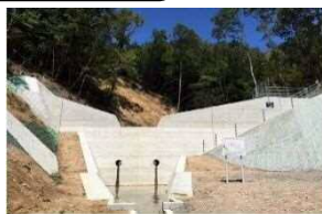
砂防堰堤(不透過型)
