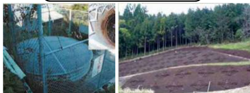
集水井工, グラウンドアンカー工
