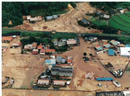
▲江内谷川（安芸太田町）で発生した土石流
