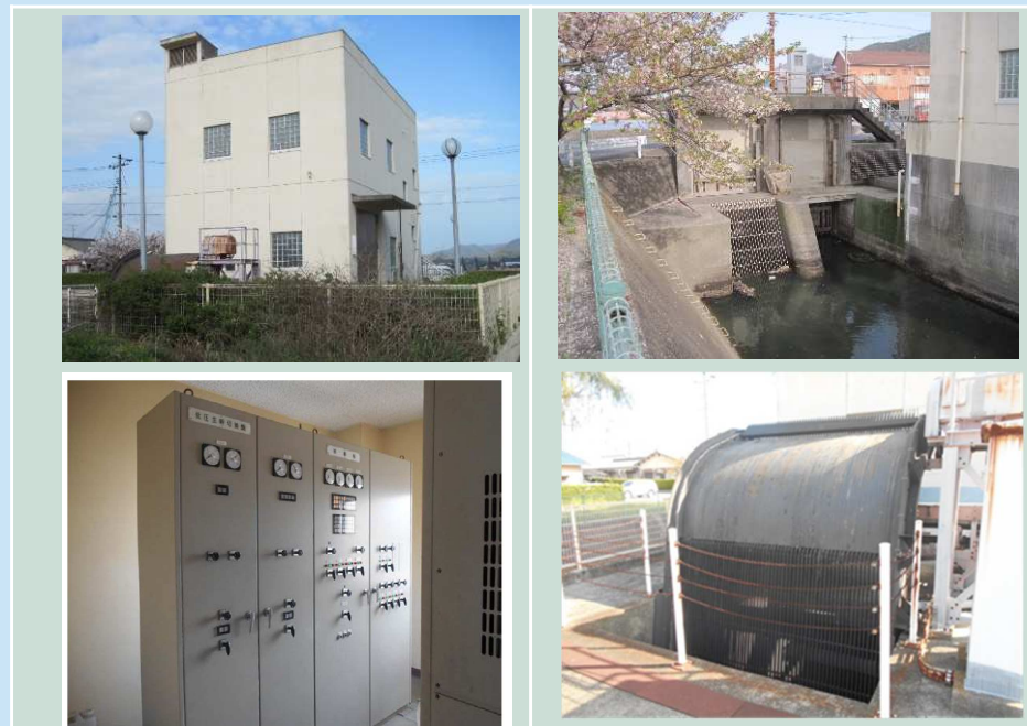
沢排水機場(尾道市瀬戸田町中野)
