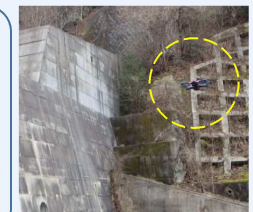
ドローンによる撮影状況
