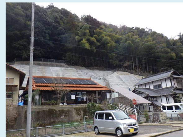
R5年度修繕事例（三次市）
