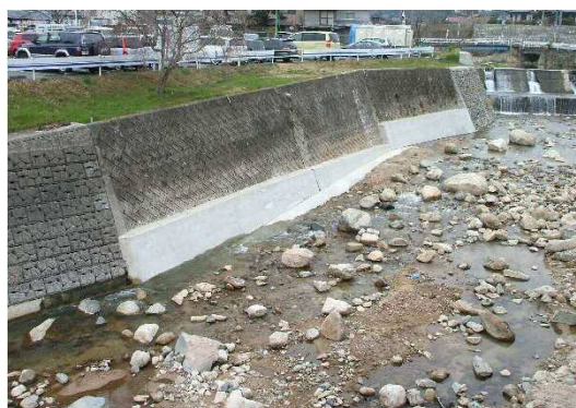
対策区分S、C 根継工による修繕
