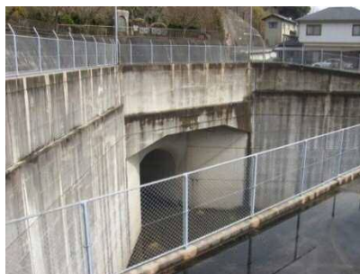
【河川トンネル 八幡川放水路】
