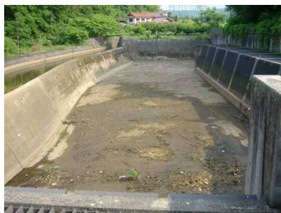
【呑口施設 片丘川放水路】
