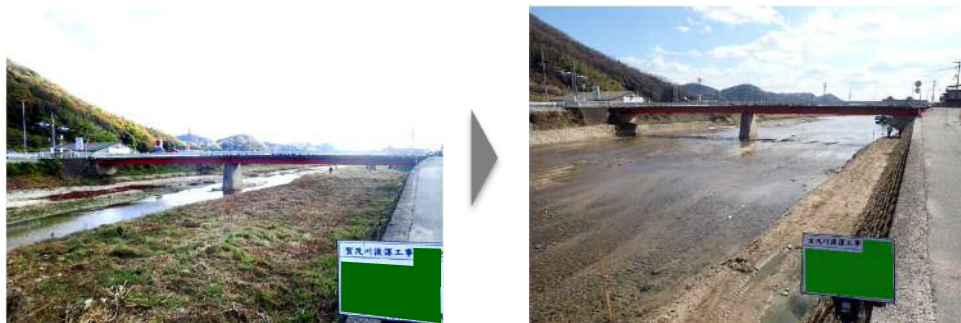
【河道浚渫事例】
