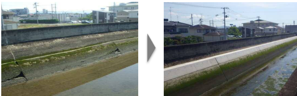
【護岸補修事例】
